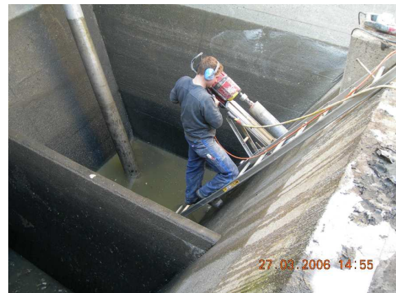
Entnahme von Bohrkerne im Pumpensumpf der Vorklärbecken
