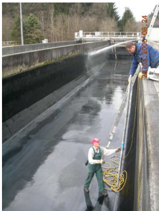
Reinigung des Vorklärbeckens Nord
