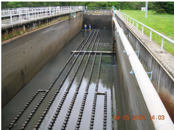
Belebungsbecken I (BB) im entleerten Zustand
