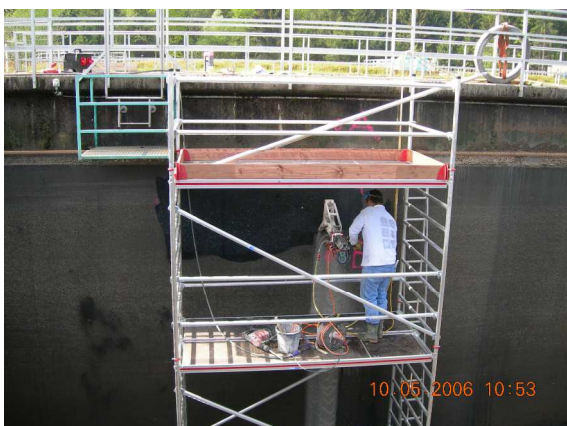
BB-II: Bohrkernentnahme Südwand
