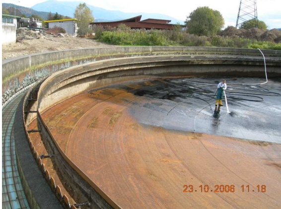
Reinigen der Bodenplatten
