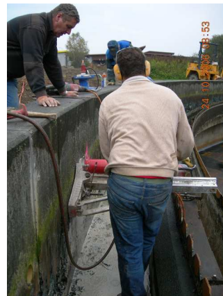
Entnahme von Bohrkernen
