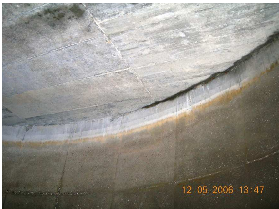
HB Radlach: Betonprüfung der Behälterdecke
