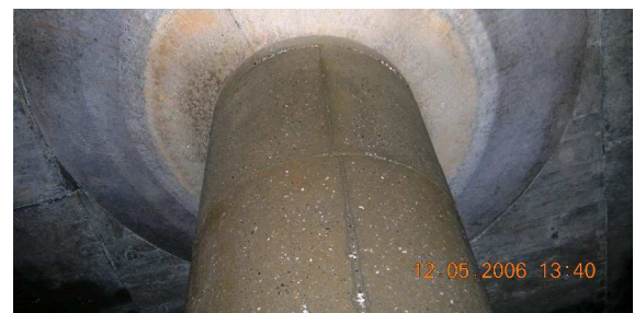
Optische und statische Prüfung der Mittelstütze
