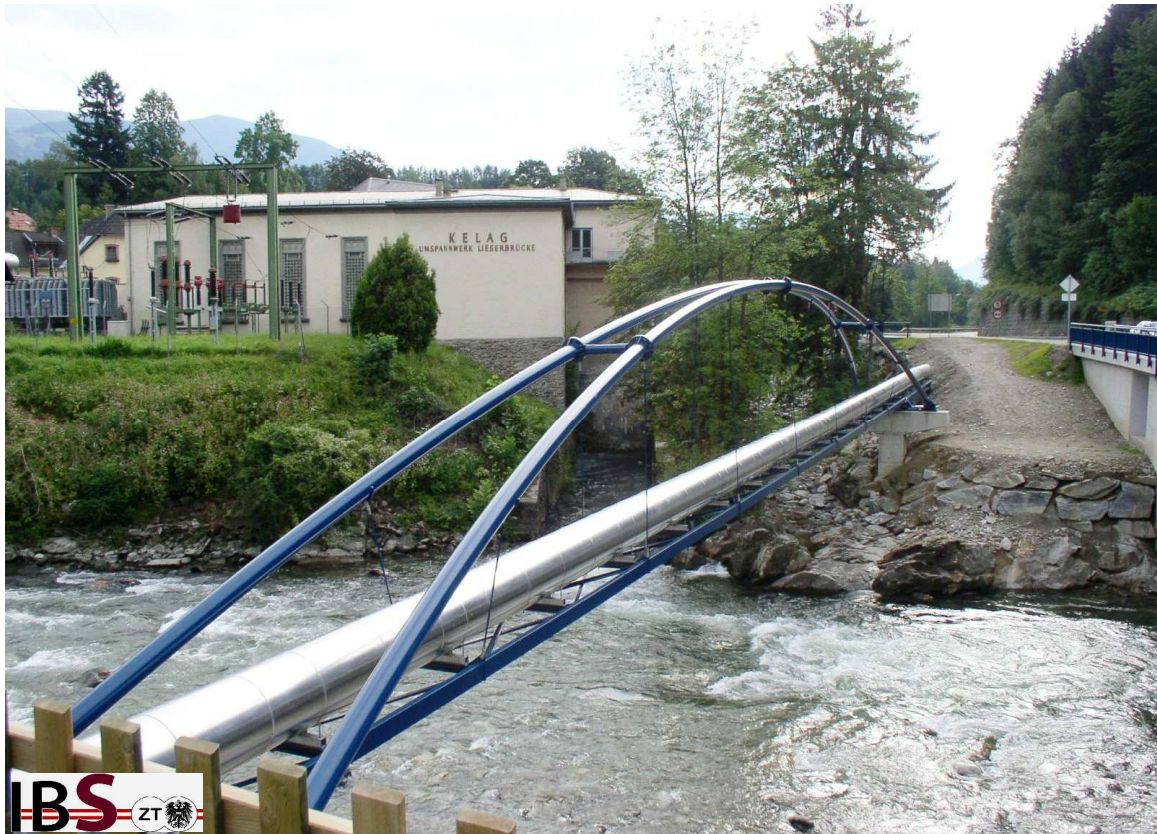
P2) Foto 03: S04-2002: Rohrbrücke über die Lieser (L= 42,5 m)
