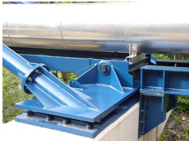
P2) Foto 04b: Bewegliches Auflager mit Bogen und Zugstabanschluss
