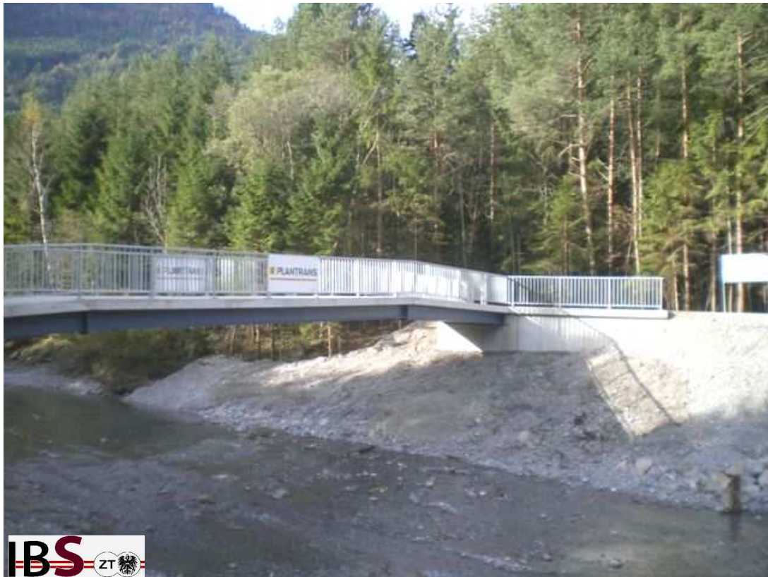
P4) Foto 07: S204-09: Die schlanke Verbundbrücke Pirknerbach (L= 26,2 m)
