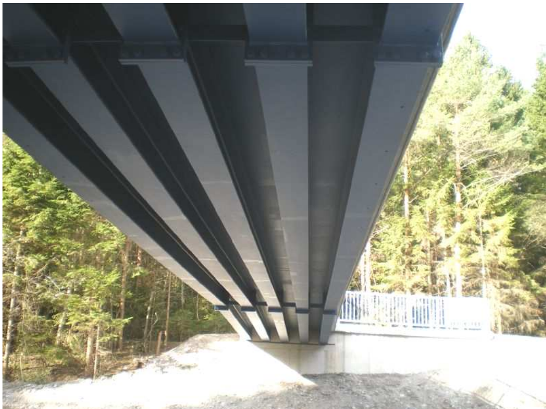
P4) Foto 08: S204-2009: Verbundträger mit Stirnplattenstößen
