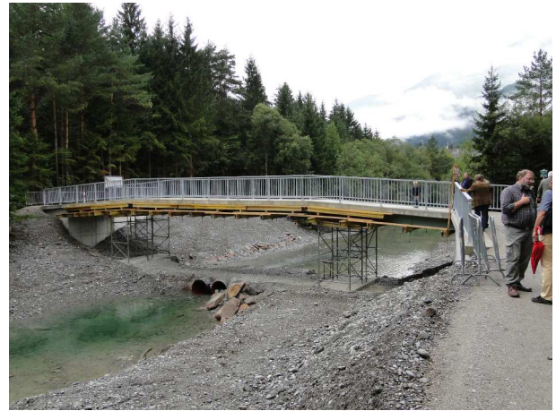
P4) Foto 09b: S204-2009: Pirknerbachbrücke im Bauzustand
