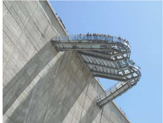
Untersicht der Konstruktion
