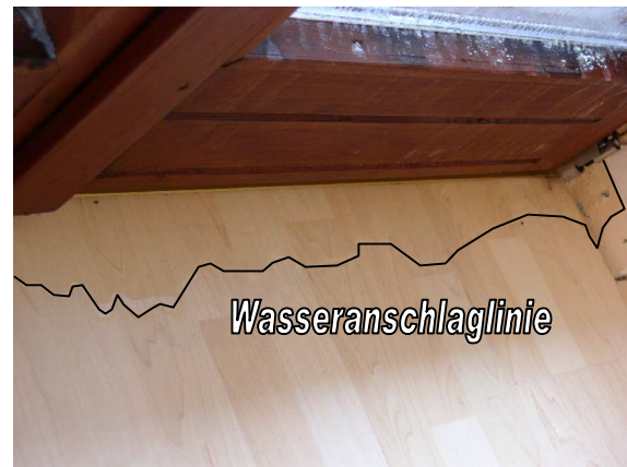
Abb. 02: Kondensatbildung vor der Balkontür
