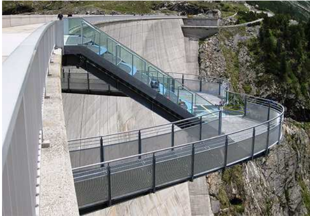
Skywalk: Ansicht von Süd
