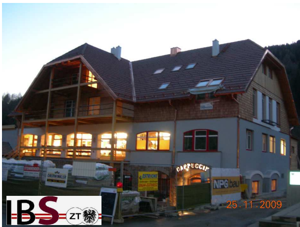
Der fertig gestellt Umbau (Nordansicht)
