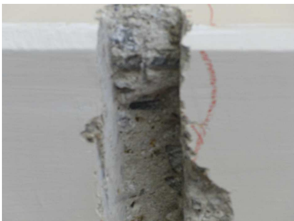
Suchschlitze zur Feststellung der Bewehrung in den Stahlbetonträgern
