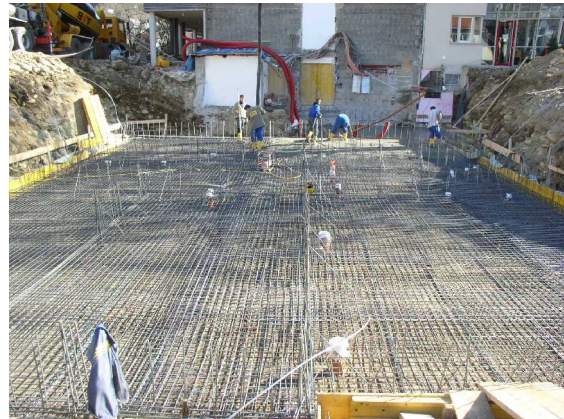
Abnahme der Bodenplatte
