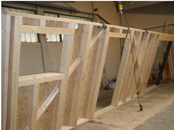
Abnahme der Holzrahmenkonstruktion (Wände)
