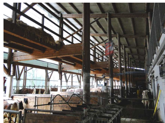
Anschluss der Hauptträger an die Stützen
