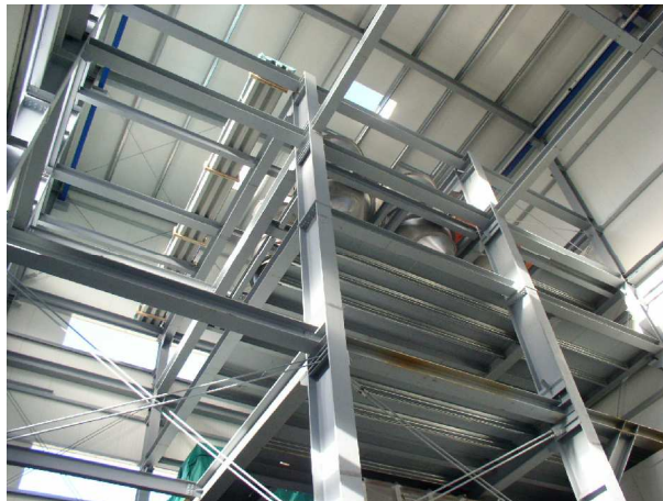
Stahlkonstruktion im Gebäudeinneren
