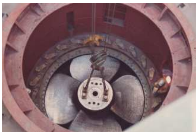
Einheben der Kaplan turbine M II; Laufraddurchmesser D = 4,20 m; Nenndurchfluss Q = 160 m 3 /s; Fallhöhe H = 9,7 m; Leistung P = 2 \times 12,5 MW; Jahresarbeitsvermögen A = 2 \times 50 GWh = 100 GWh
